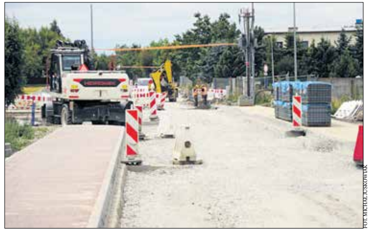
II etap budowy ul. Leśnej w Dąbrowie.
