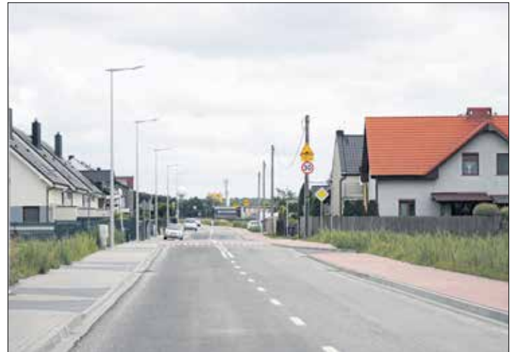
I Etap budowy ul. Leśnej w Dąbrowie - zakończony.
