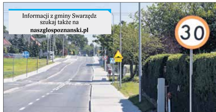
W Gruszczynie zakończyła się budowa ul. Katarzyńskiej.
