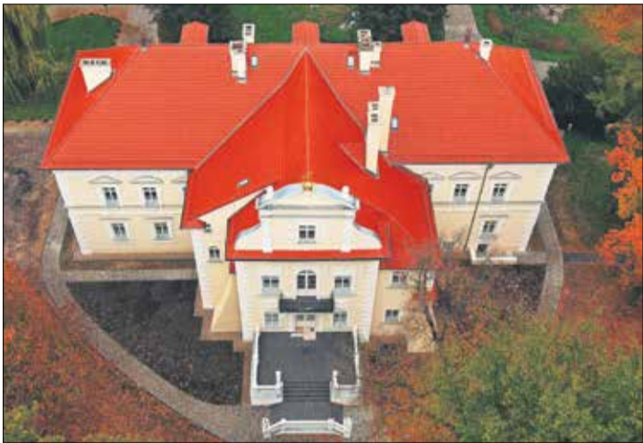
Pałac po remoncie.
