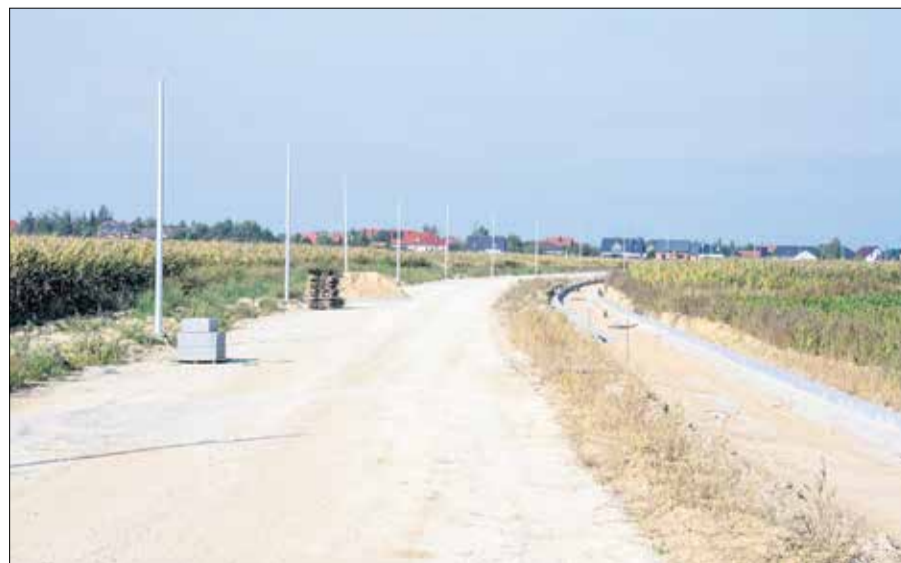
Zaawansowana jest budowa obwodnicy Pobiedzisk.
