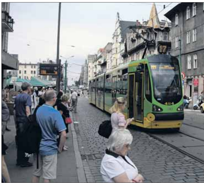
Torowisko na ul. Dąbrowskiego, od Rynku Jeżyckiego do ul. Mickiewicza, nie przeszło generalnego remontu od czasu powstania w latach 60.
