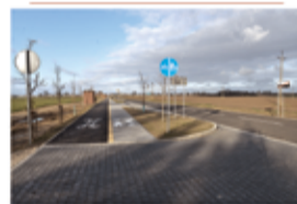
Droga powiatowa P2477 Przebudowa Łączna kwota inwestycji: niespełna 40.000.000,00 zł
