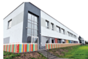
Skola Podstawowa w Radzewie Termomodernizacja i rozbudowa Łączna kwota inwestycji: 9.199.523,56 zł
