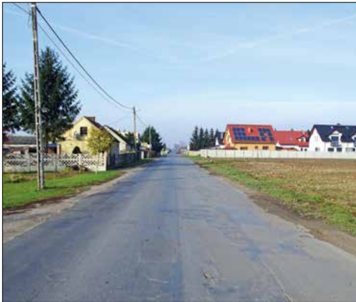
Droga w miejscowości Dachowa.
