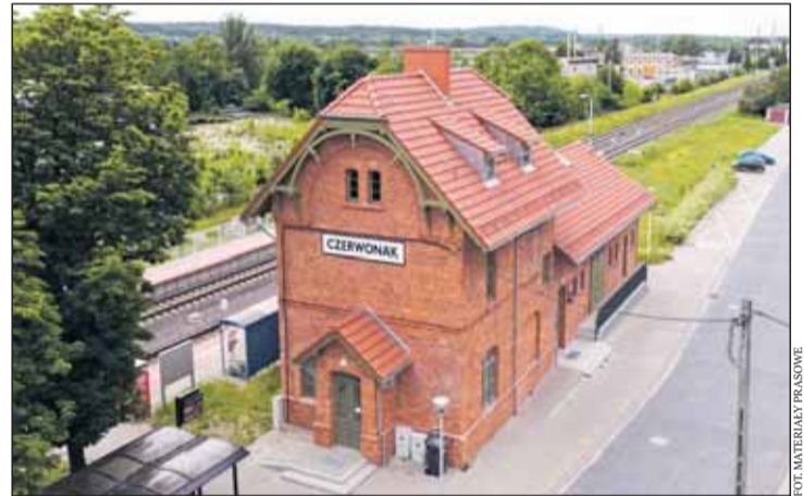
...i po remoncie.
