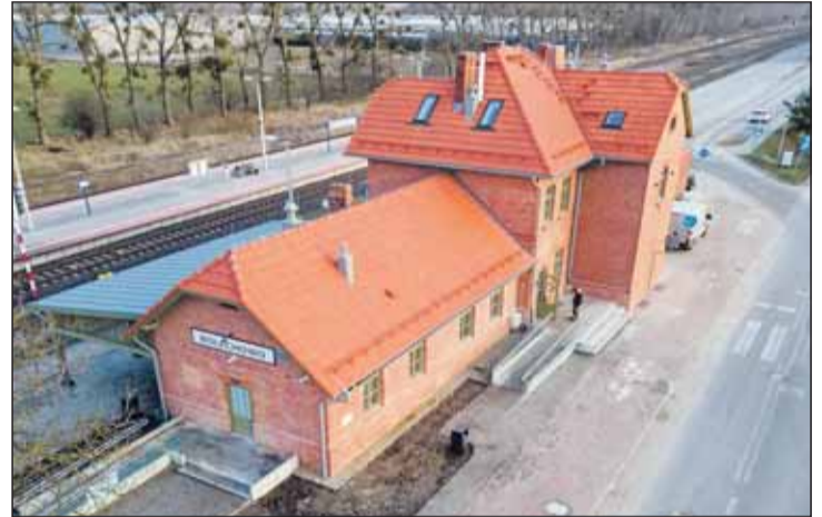
...i po remoncie.
