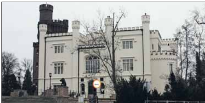
Odnowiono zachodnią fasadę Zamku w Kórniku.
