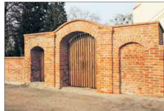
...i po remoncie.
