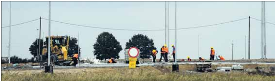
Na węźle Mosina wznowiono prace.
