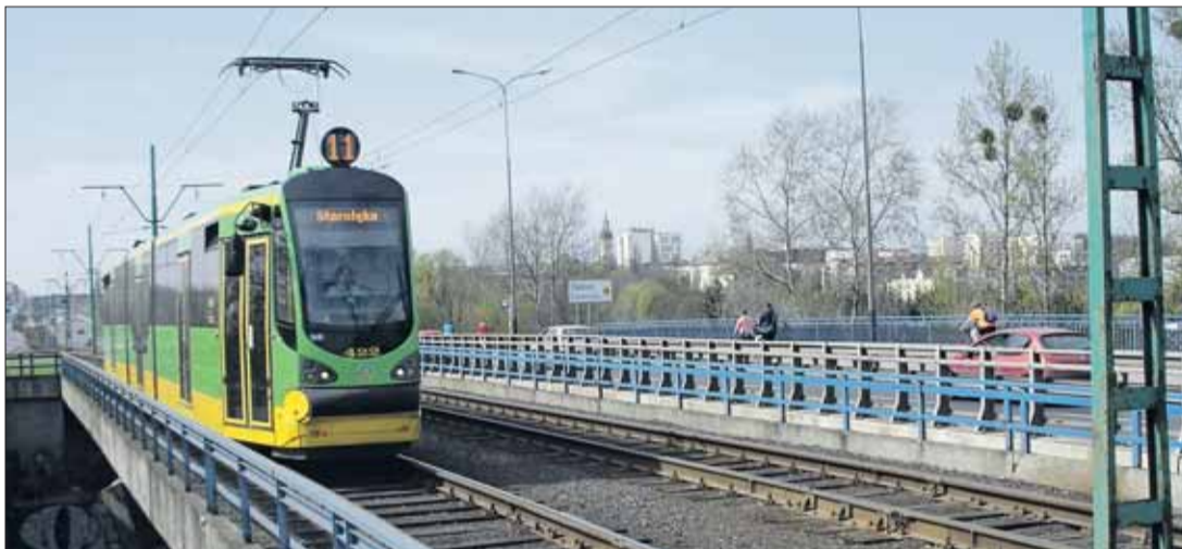
21 kwietnia rozpoczęła się przebudowa torowiska na ul. Hetmańskiej od wiaduktu nad ul. Dolna Wilda do ronda Starołęka.
