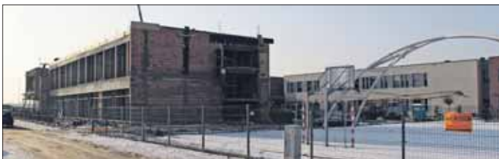
Trwa budowa nowego skrzydła gimnazjum w Rokietnicy.
