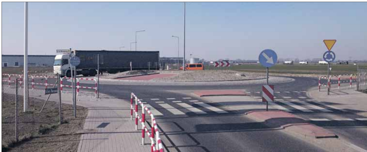
Przy okazji budowy obwodnicy powstało rondo, które znacznie poprawia bezpieczeństwo jadących.
